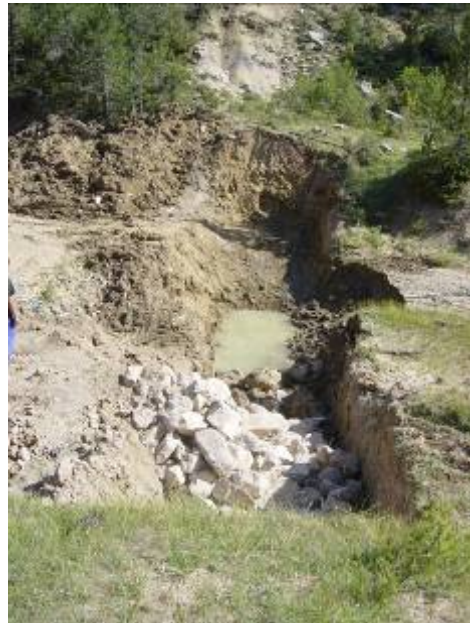
Fig. ... refuerzo de la cimentación
